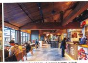
柱、梁に木質耐火部材 [COOL WOOD] を使用した室内
