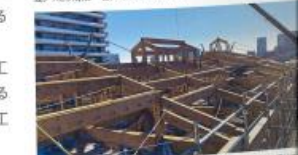
屋根部分躯体施工状況
