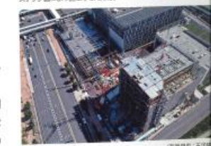
掘削時の施工状況
